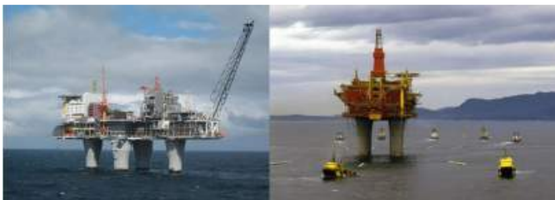
Slika 1.7 Betonske gravitacijske platforme (izvor: http://en.wikipedia.org )
