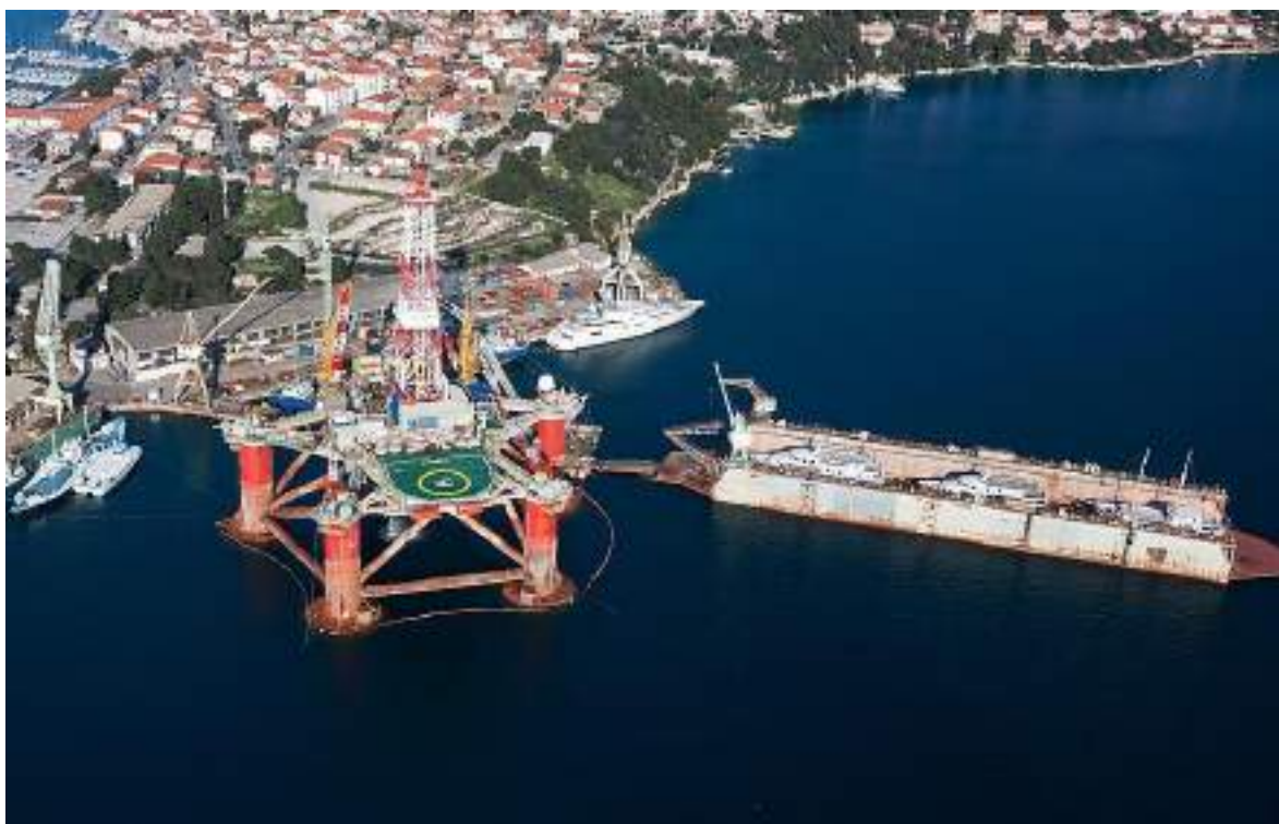
Slika 3.85 Platforma Zagreb 1 u trogirskom brodogradilištu
