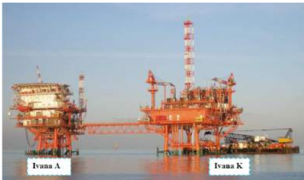
Slika 1.4 Eksploatacijska platforma Ivana A i kompresorska platforma Ivana K
