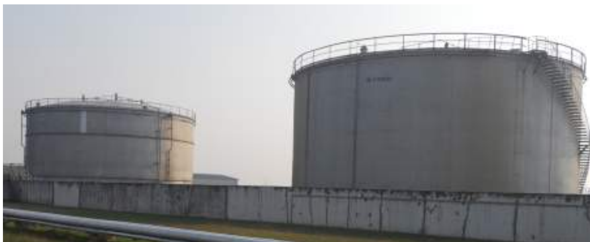
Slika 1.30 Spremnici za skladištenje nafte s fiksnim krovom
