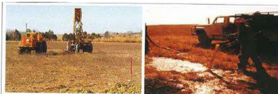
Slika 1.5 Izrada (lijevo) i miniranje (desno) seizmičke bušotine (izvor: Prskalo, 2005.)
