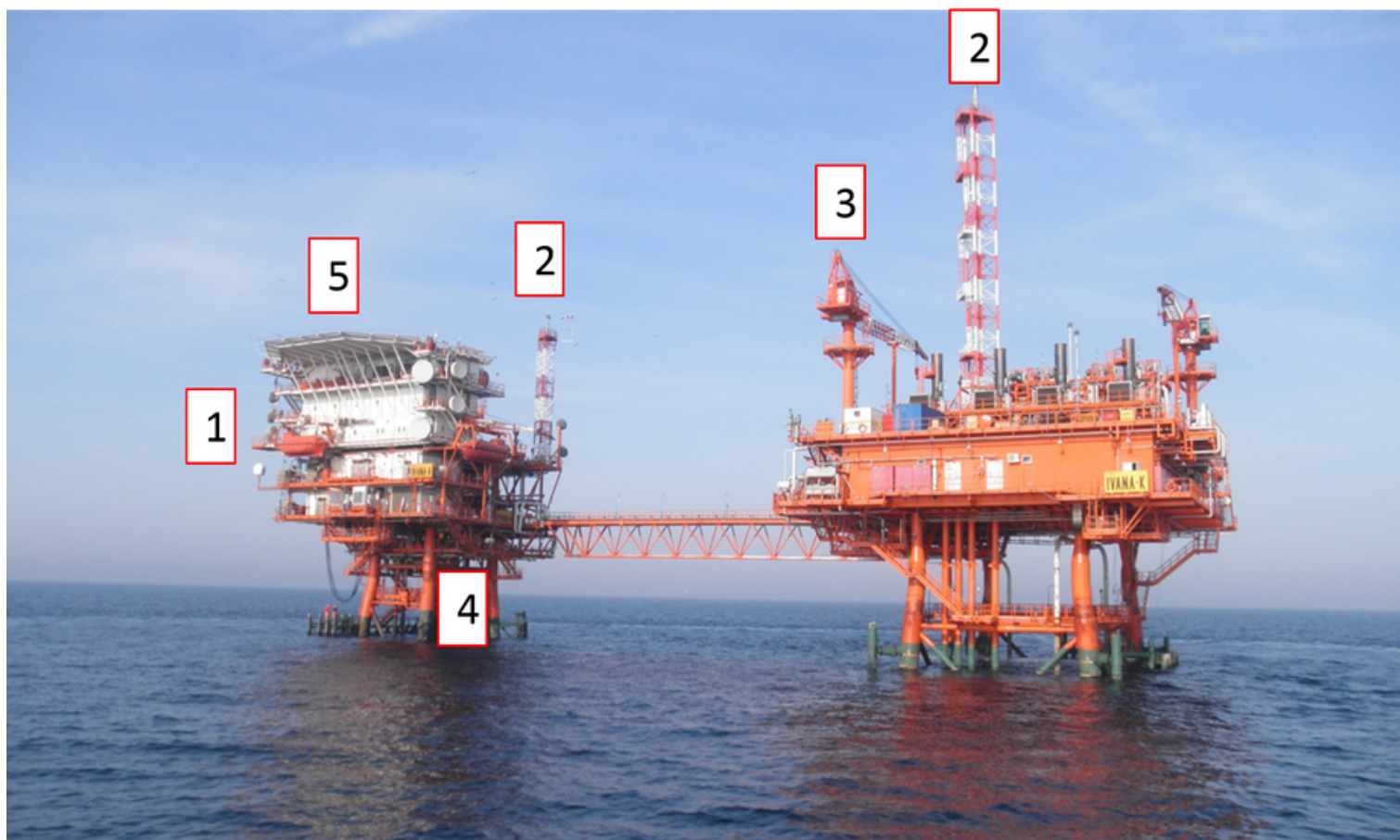
Slika 3. Primjeri SECE na platformi Ivana A-K: 1. brodica za spašavanje, 2. vertikalni ispuh postrojenja, 3. dizalica/kran, 4. sustav pridobivanja ugljikovodika, 5. helikopterska paluba
